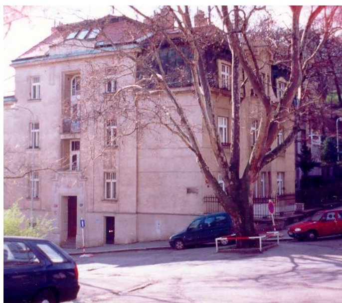
Dům v Bieblově ulici 21 v Praze 5, v jehož přízemí Vandovi bydleli.
