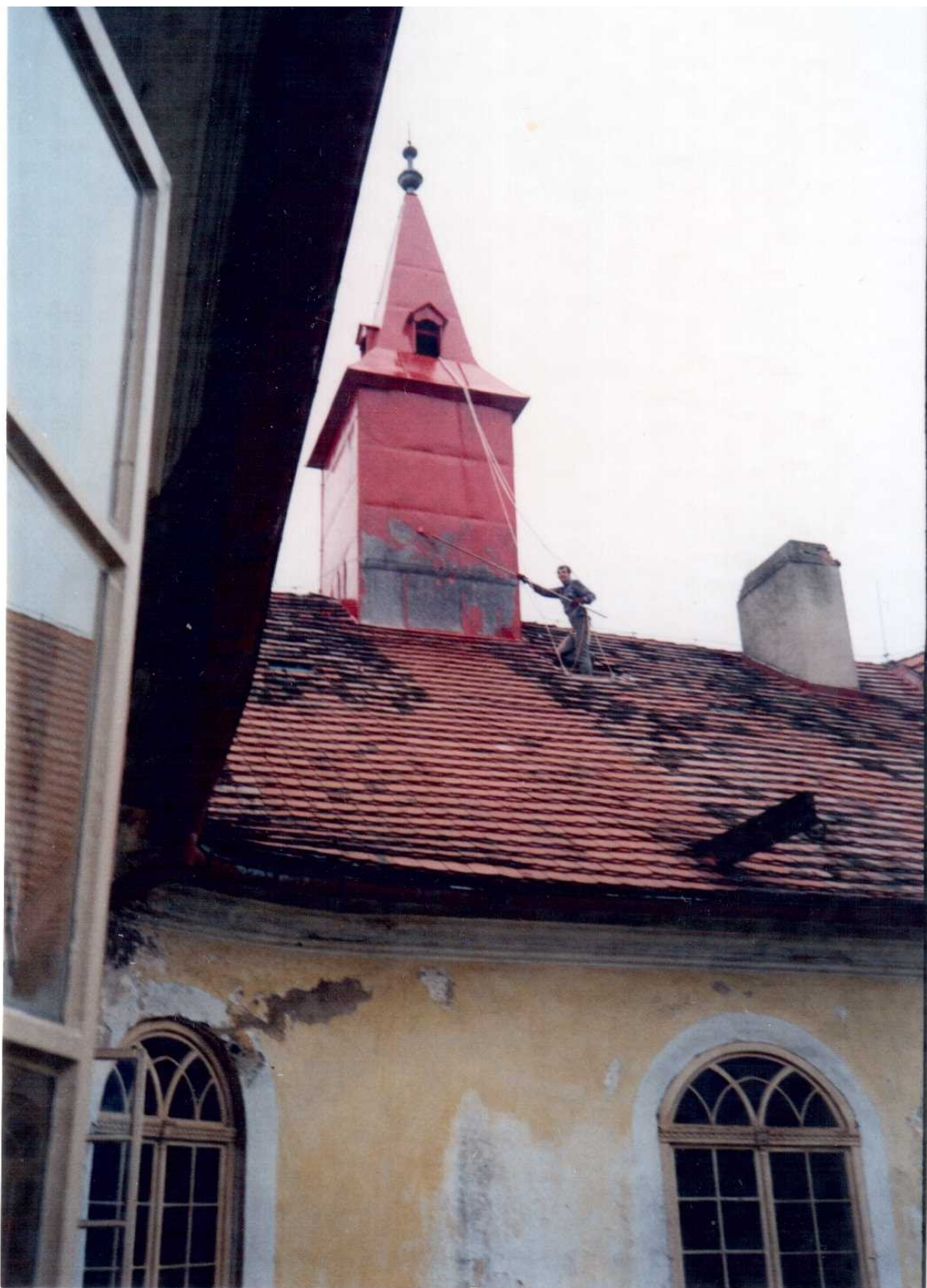
Na natření věžičky zámku v Osečanech jsem spotřeboval asi 20 kg červené barvy.
